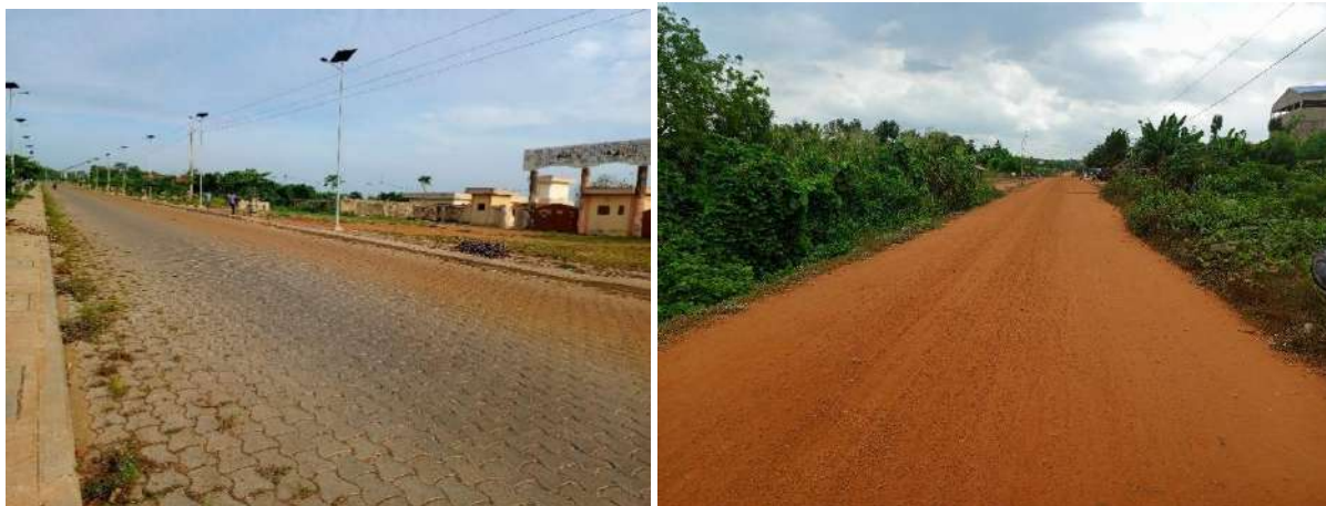
a : Voie pavée Lokossa- Houin menant au LTP Lokossa ; b : Voie non aménagée quittant Houin pour le centre-ville de Lokossa
