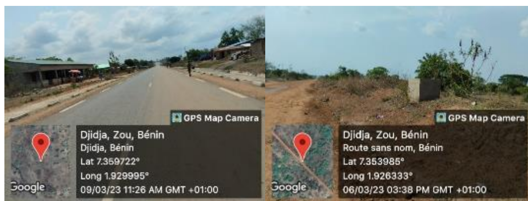
Planche 11 : Etat de la voie d'accès au site
