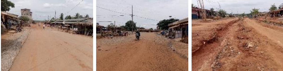
Planche 8 : Voie d'accès au site du LTA D'ADJA-OUÈRÈ
