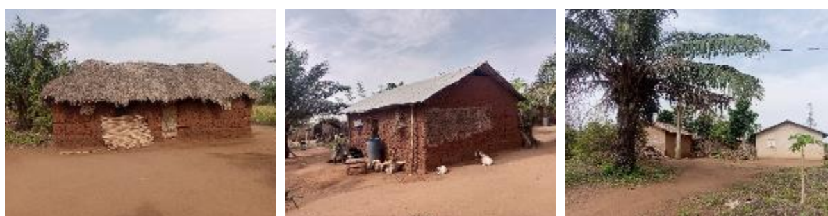
Planche 7 : Habitations présentes sur le site de construction du LTA d'Adja-Ouère
