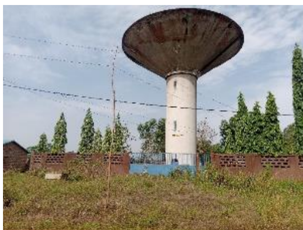
Photo 3 : Château d'eau présente sur le site de construction du LTA D'ADJA-OUÈRE
