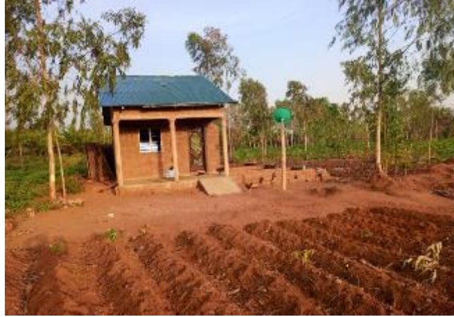
Photo 4 : Habitation présente sur le site de construction du LTA Prise de vue : CONCEPTIS SARL, mars 2023
