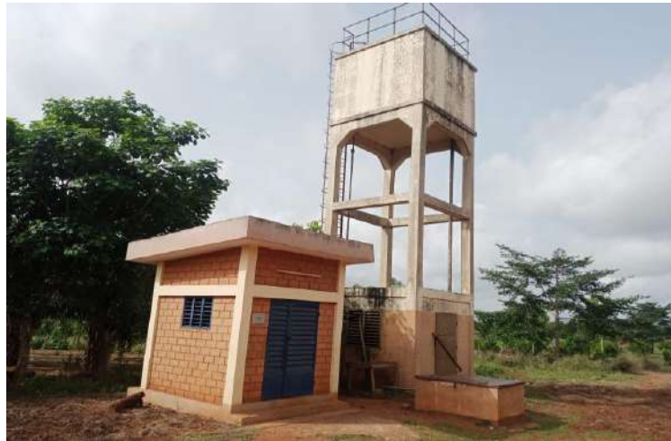
Photo 1 : Château d'eau de Djikpamey à proximité du site Prise de vue : AERAMR Conseils, Mars 2023
