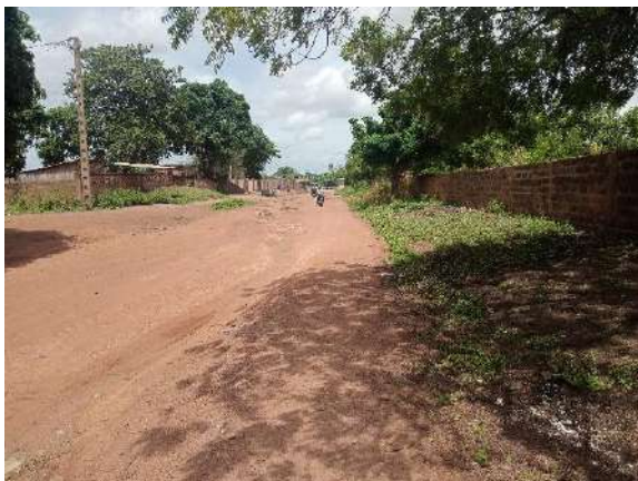
Voie menant au site du côté Est
