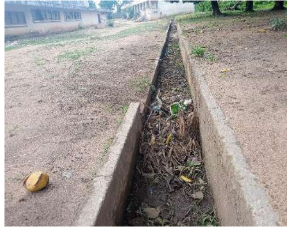
Canaux de canalisation des eaux pluviales
