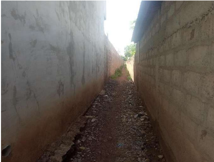
Photo 1 : Distance entre la clôture du lycée et la première habitation la plus proche
