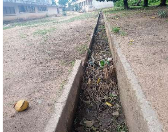
Canaux de canalisation des eaux pluviales
