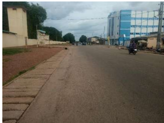
Voie menant au site du coté ouest par l'entrée principale du LMB
