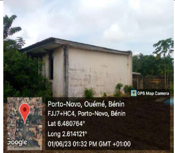
Bâtiment ENI délaissé
