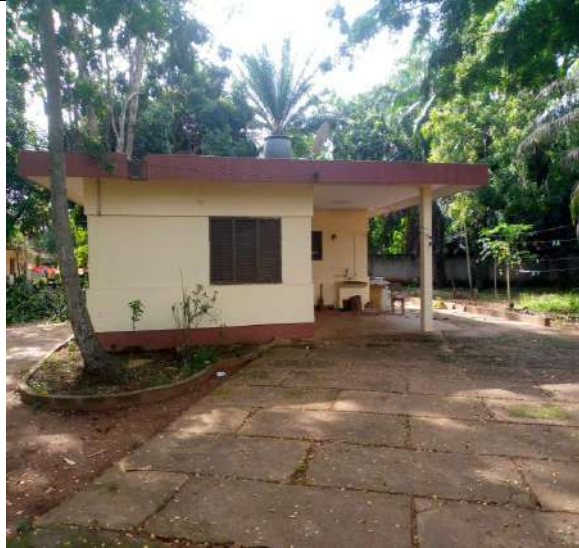
Résidence du personnel délaissée
