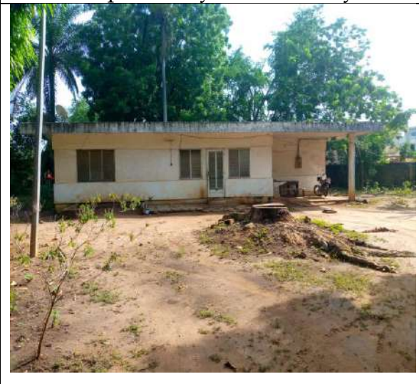
Résidence du personnel délaissée
