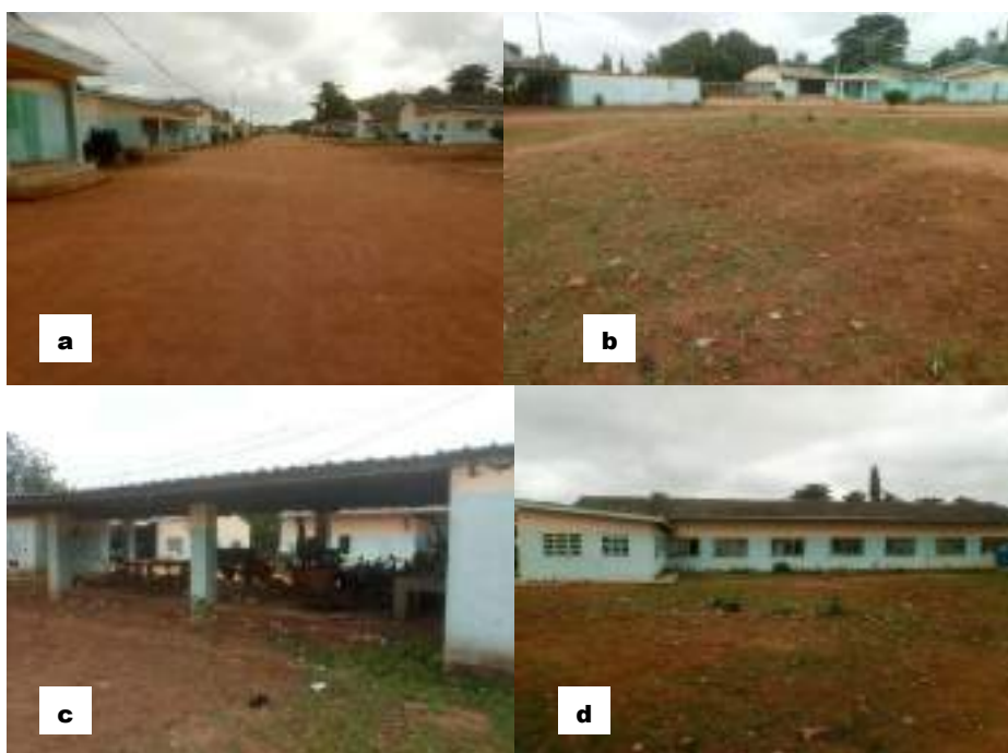
a : Voie d'accès au site en partant de l'entrée principale ; b : Vue d'ensemble du site ; c: garage des équipements AER limitant le site au Sud ; d : Bâtiment A limitant le site au Nord
