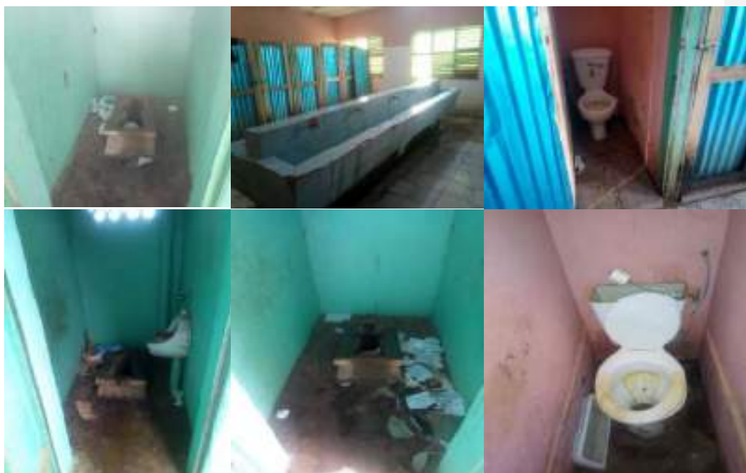
Planche 15: Etat des installations d'hygiène au niveau du LAMS
