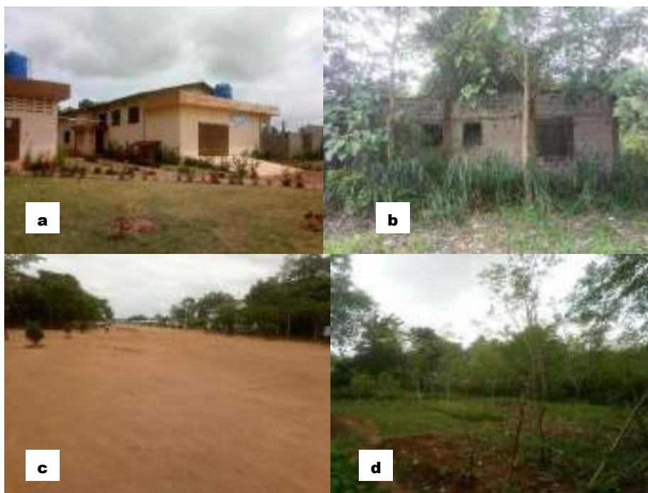
a : Bâtiment de l'incubateur qui limite le site au Nord ; b : Bâtiment abandonné se trouvant sur le site ; c : Aller principale et bâtiment K limitant respectivement le site à l'Est et au Sud ; d : Présence de pépinières issus de la pratique des apprenants du secteur foresterie
