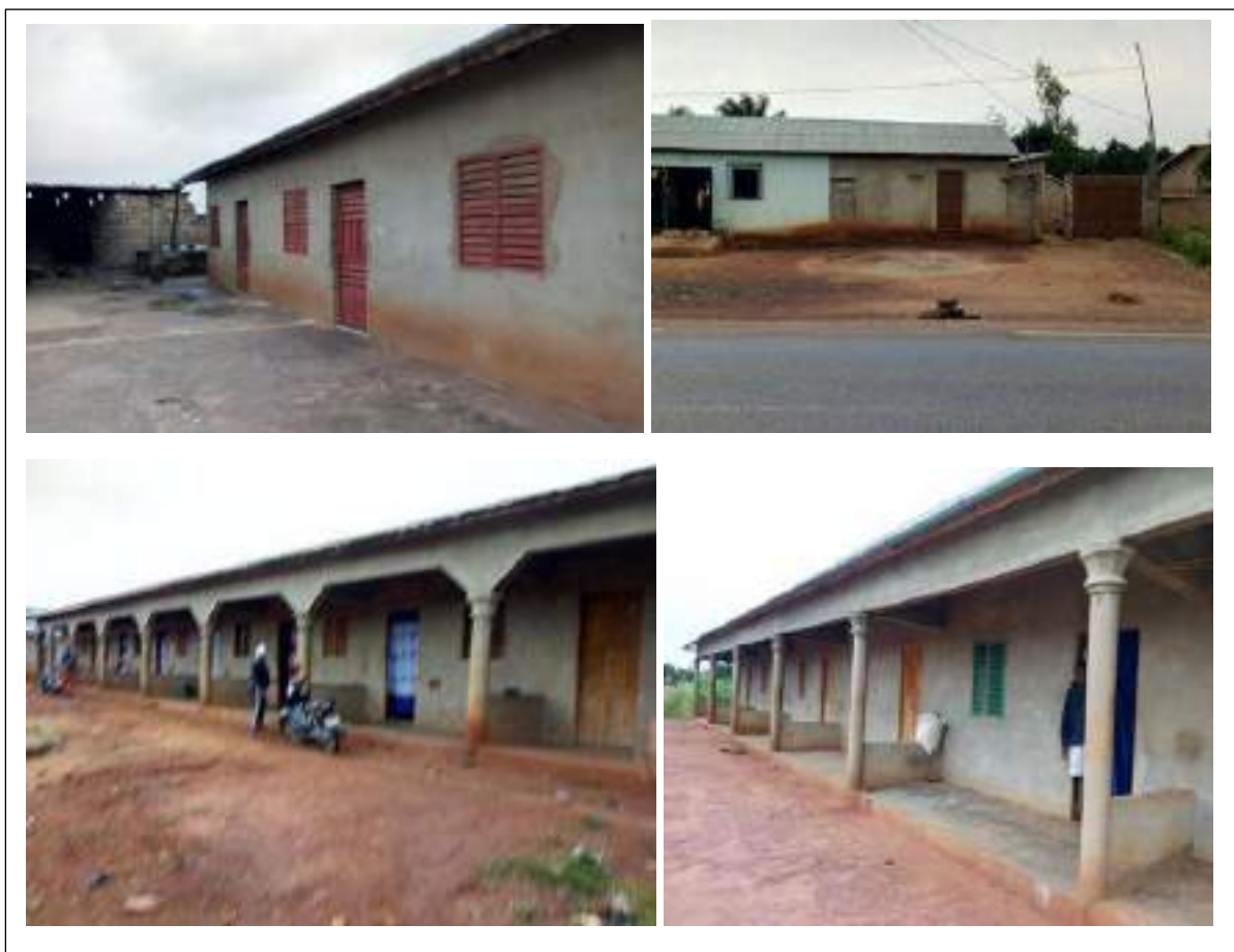
Planche photographique 3: Quelques habitations autour du Lycée d'Adjahonmè Prise de vue : AID, Août 2020
