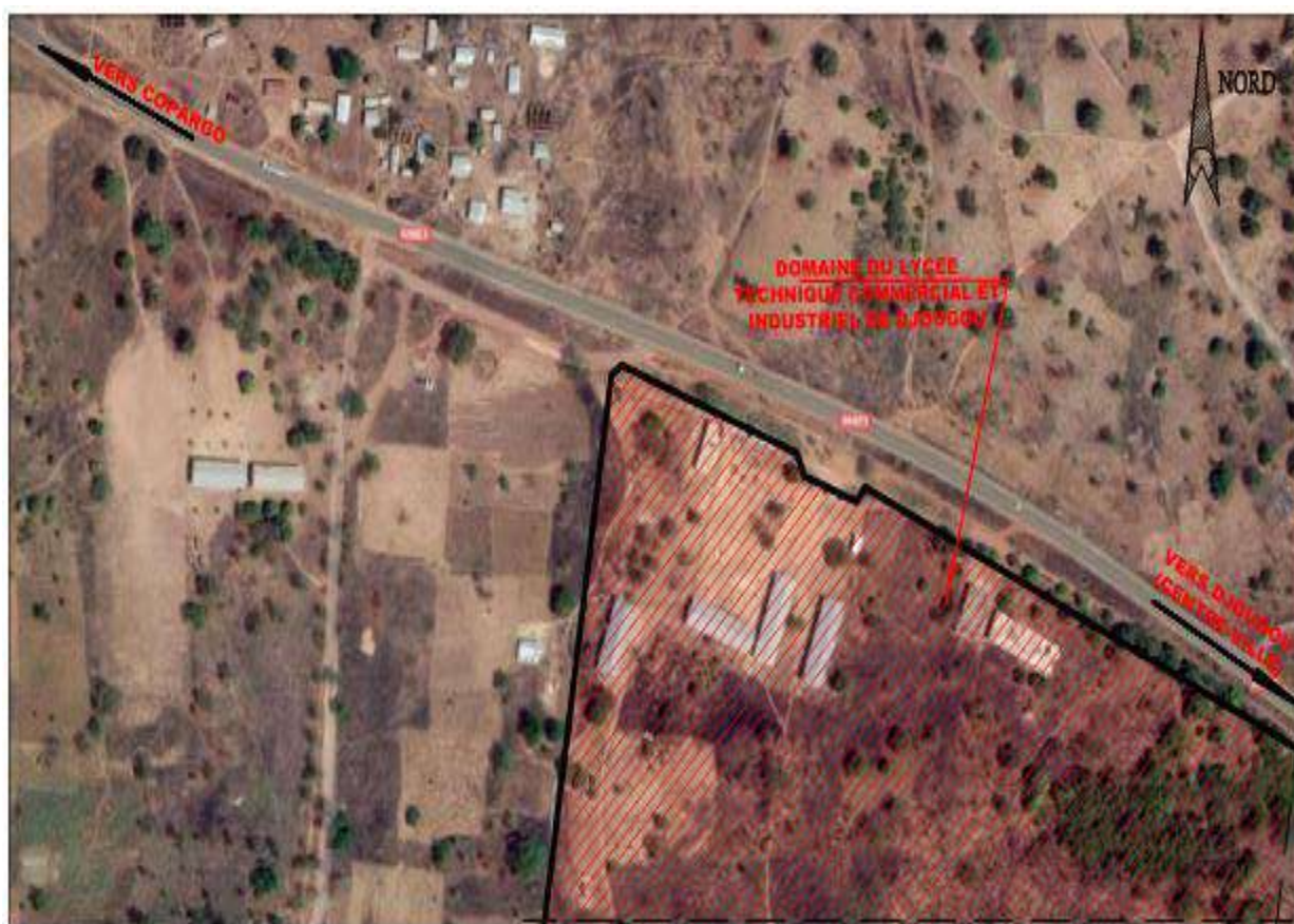
Figure 6 : Présentation du site du projet et de son environnement immédiat
