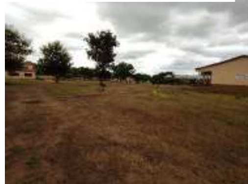
Photo 8 : Bloc module de classe
