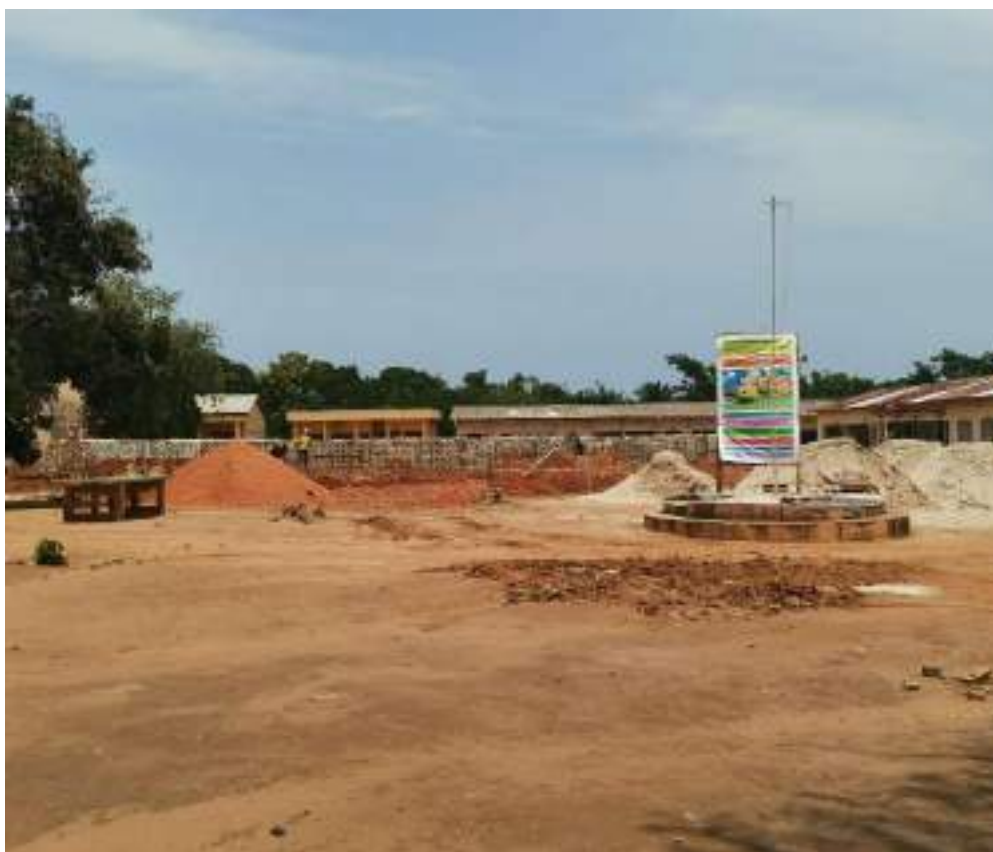
Photo 1 : Nouveau bloc administratif en construction par le Lycée sur fond propre Prise de vue : CREDD, août 2020
